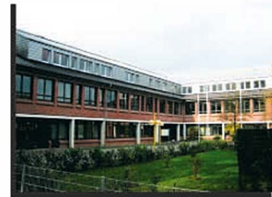
Dachgeschoss Fensterelemente; Lichtdächer Gymnasium Trittau
