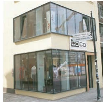
Wohn- und Geschäftshaus Kröpelin Str. 44 - Rostock
