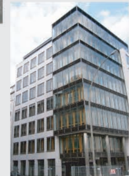
Wohn- und Geschäftshaus Glockengießerwall Hamburg
