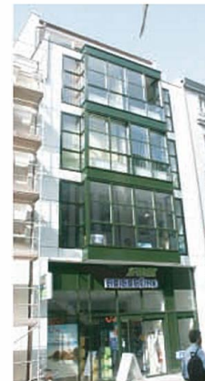
Wohn- und Geschäftshaus Kröpelin Str. 54 - Rostock
