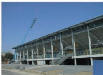
Ostseestadion Promenadenverglasung Rostock
